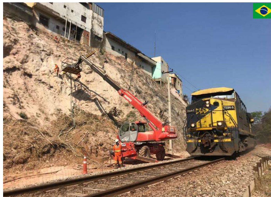
Espaço confinado, compacto, acidentado e com trilhos
