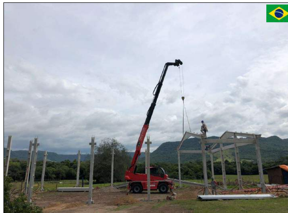
Íçamento de Estruturas, geralmente executado por Muncks e Guindastes
