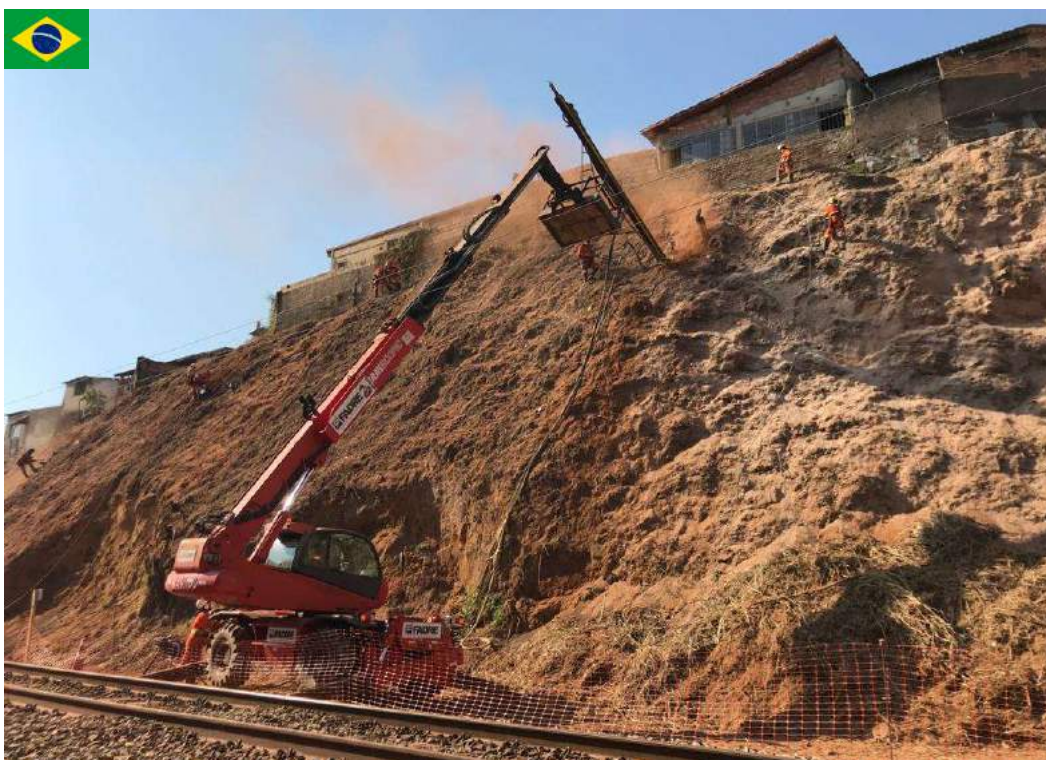
Perfuração em Grandes Alturas para Contenção OBS: fotos tiradas de aplicações no Brasil
