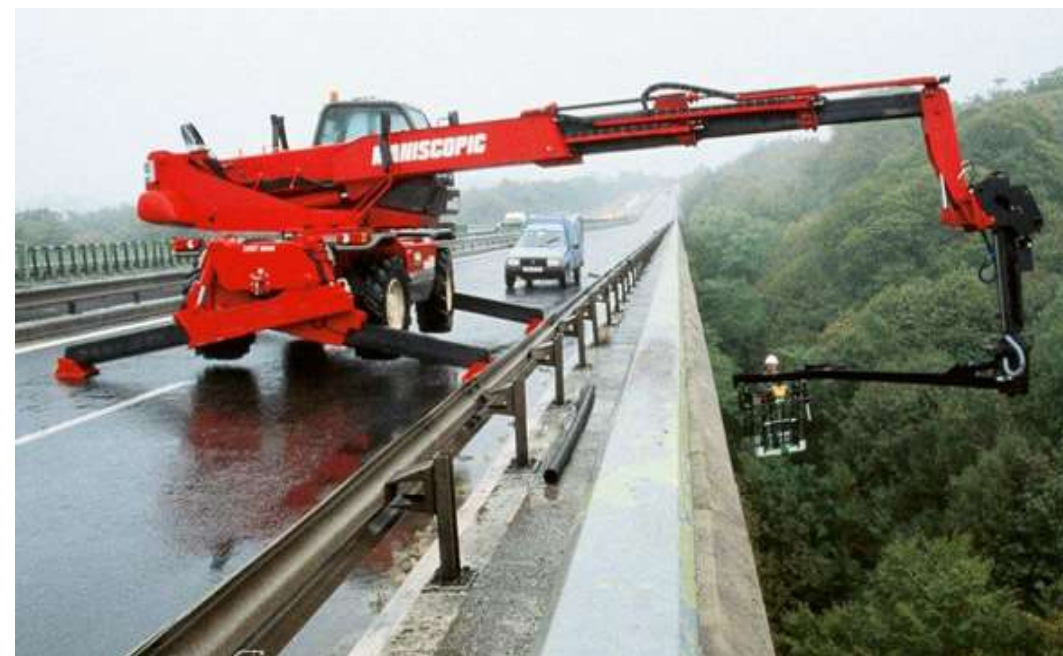
Operações com Cesto em Negativo
