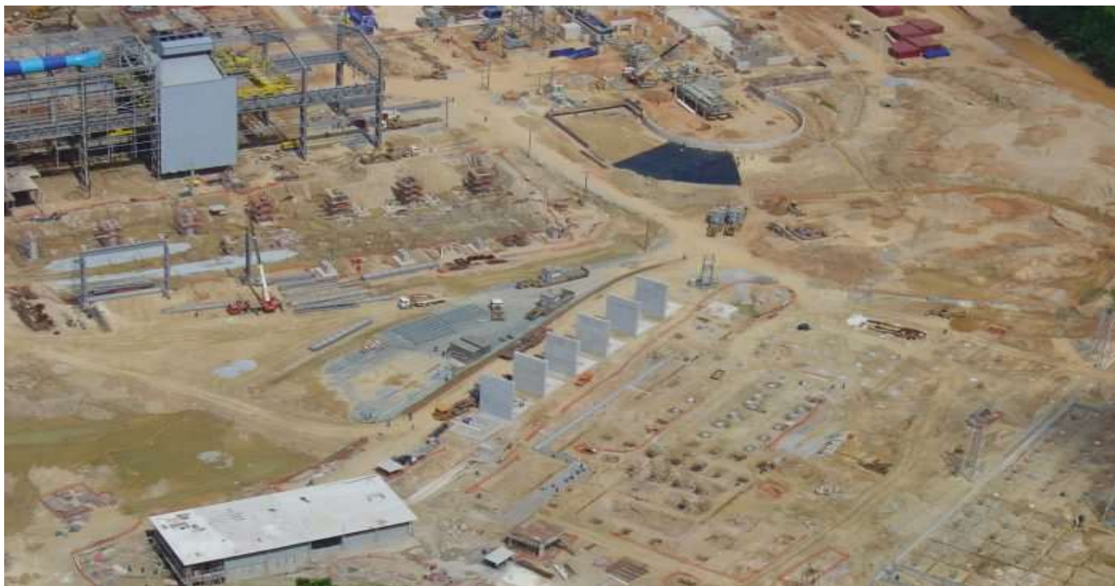
GERDAU – Araçariçuama-SP - Inicio
