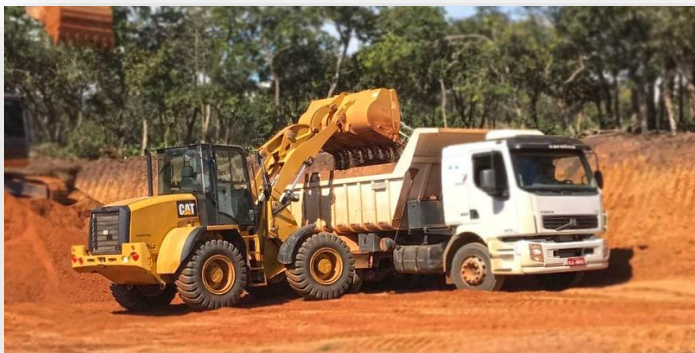
CARREGAMENTO DE CAMINHÃO
