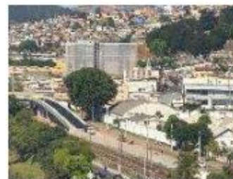
Viaduto Augusto Franco
