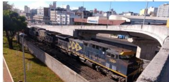
Viaduto Hélio Fadel Araújo
