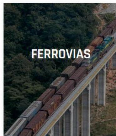
OBRAS DE ARTE ESPECIAIS E CORRENTES
