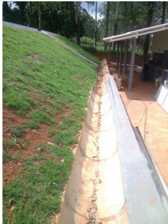
Drenagem com plantio de grama para evitar carreamento de material – Usina de Asfalto – Tamasa Engenharia S/A
