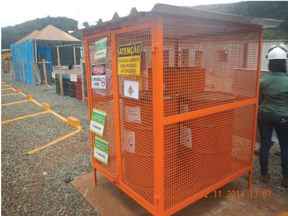
Depósito de Resíduos Classe 1. Obra da Construtora Sant'Anna Ltda. 2014.
