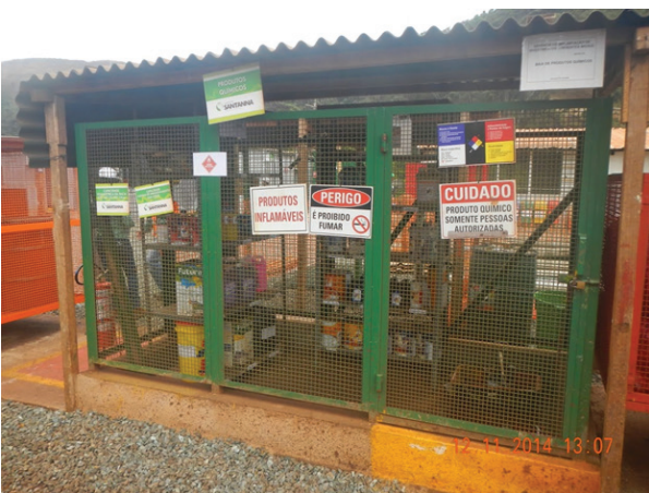
Depósito de Produtos Químicos e Inflamáveis. Obra da Construtora Sant'Anna Ltda - 2014.
