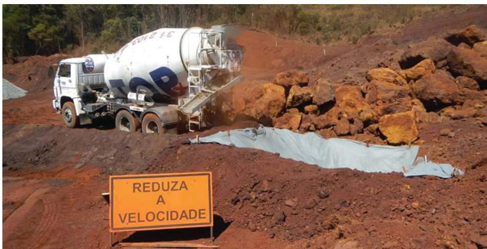
Local para lavagem de Bicas de Concreto. Obra da Construtora Sant'Anna Ltda - 2014.
