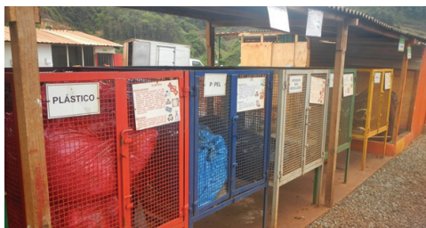
Baias Metálicas Suspensas de Resíduos. Obra da Construtora Sant'Anna Ltda. 2014.
