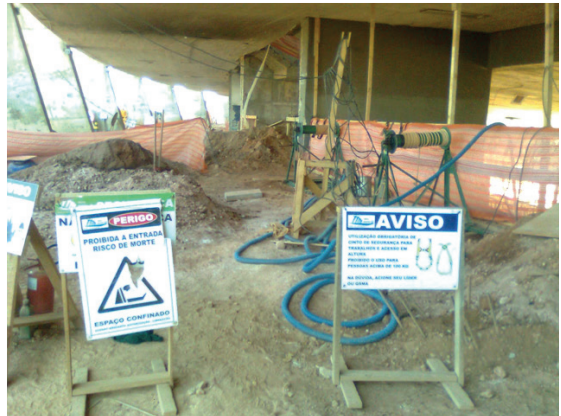
Sinalização de canteiro de obras. Obra do Mineirão, EGESA Engenharia S/A, 2012.
