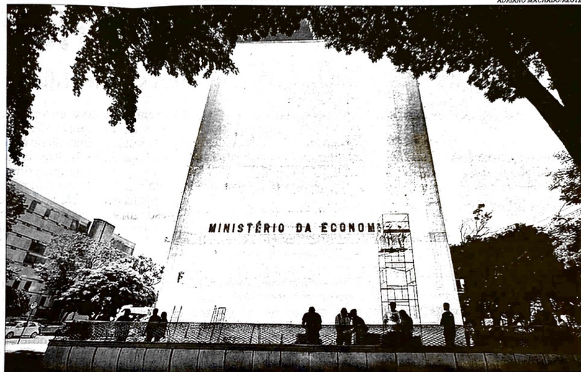
Ministério da Economia está em fase final de elaboração do sistema que irá possibilitar as operações pelas empresas
